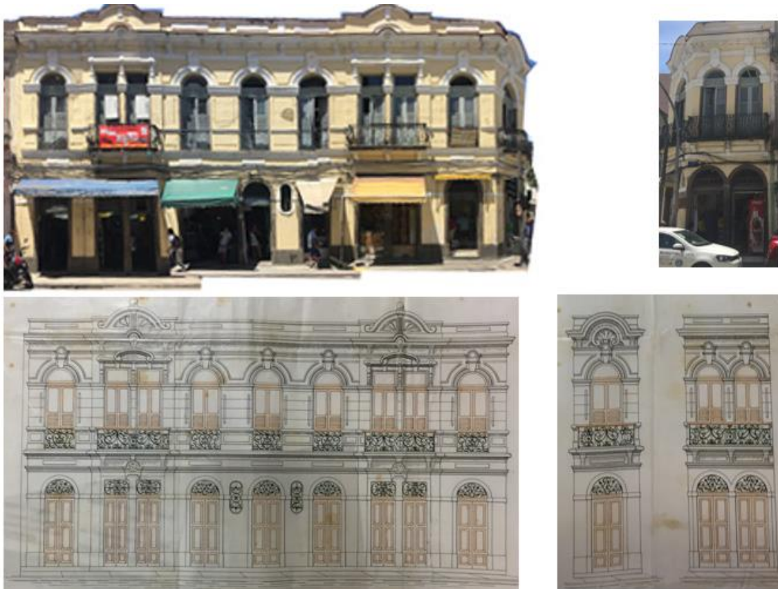
Figura 43: Tipos formais encontrados na região: sobrado da Rua da Constituição nº 66. Fonte: Arquivo da Cidade do Rio de Janeiro e foto da autora. (2016).
