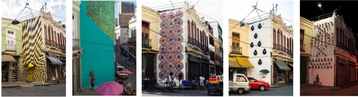
Figura 107: Exemplos de intervenções realizadas na empena lateral da edificação onde funciona a Galeria de Arte Gentil Carioca localizada na Rua Gonçalves Ledo. Fonte: http://agentilcarioca.com.br/projetos/parede-gentil/ Acesso em Julho de 2017
