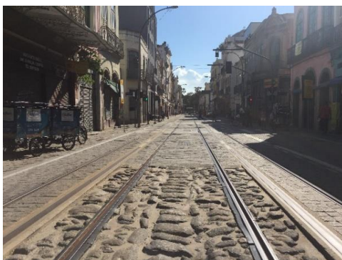
Figura 121: Trecho de piso pé de moleque na Rua da Constituição. Foto da autora (2017).
