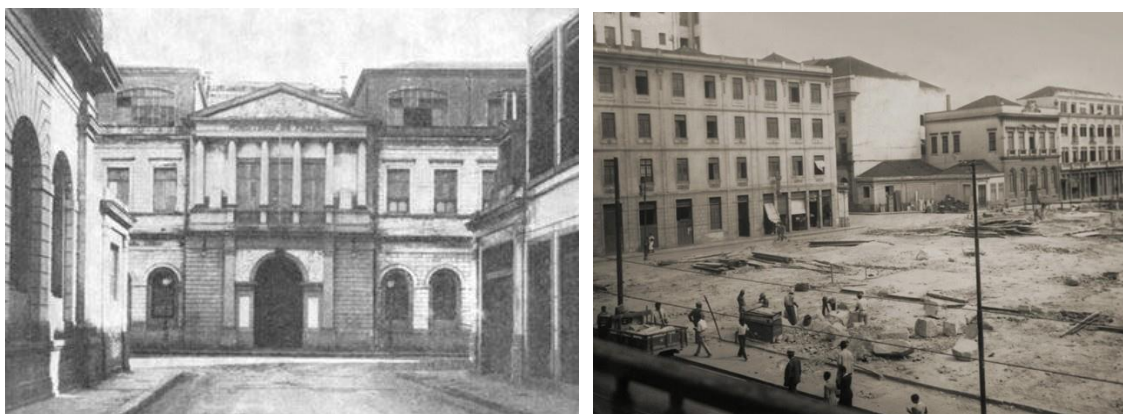
Figura 20: Edifício da Escola Nacional de Belas Artes e Travessa Belas Artes logo após a sua demolição em 1938 (Foto: Arquivo/Mongeral Aegon) Fonte: http://www.eba.ufrj.br/pintura/ e http://g1.globo.com/rio-de-janeiro/rio-450-anos/noticia/2015/02/traveessa-belas-artes-no-centro-do-rio-sera-rua-de-pedestres-apos-obra.html
